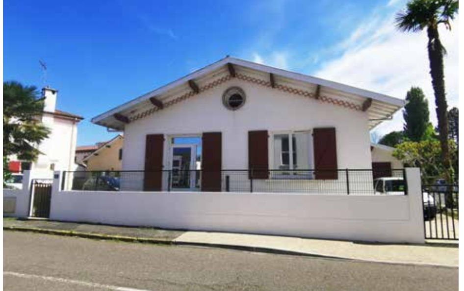
Maison «Labat» , qui accueille désormais le pôle SEVA.
