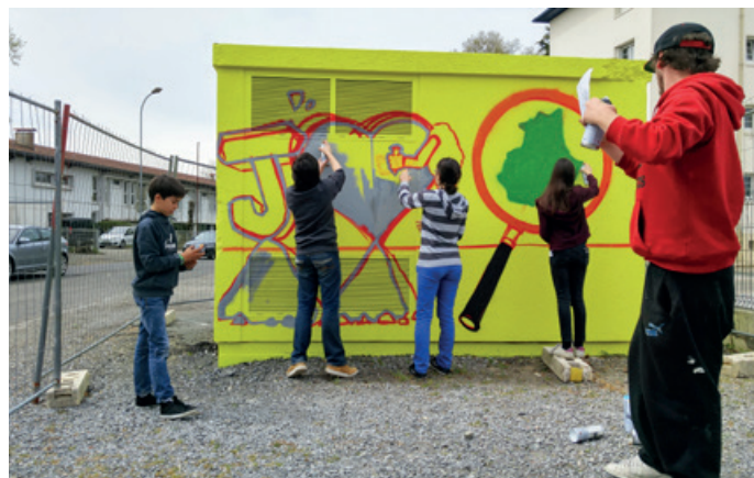
Habillage d'un poste transformateur ERDF par les adolescents.
